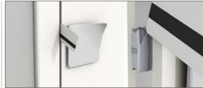
**Insira um cartão de plástico na ranhura da porta na altura da fechadura, usando-o para sentir a borda superior da trinca. Em seguida, deslide a parte inferior do cartão para o recesso no lado da trinca. Agora puxe para baixo verticalmente até parar na borda da porta. O trinco agora está empurrado e a porta pode ser aberta. Apenas remova o cartão do recesso depois de abrir /**
